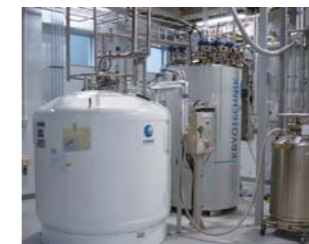
極低温量子科学施設 液体ヘリウムを作る装置が平成23年3月末に新しいものに更新されました。
